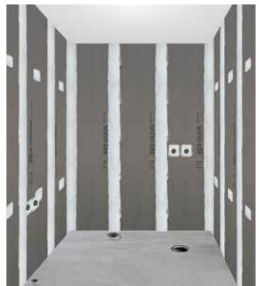
Sivele vedeneristettä nauhojen ja läpivientikappaleiden päälle.
