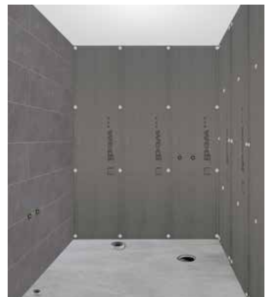
Vahvista kiinnitys wedi-kiinnikkeillä.
