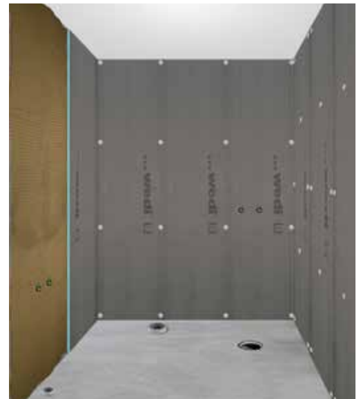
Asenna levyt painamalla ne voimakkaasti seinään.
