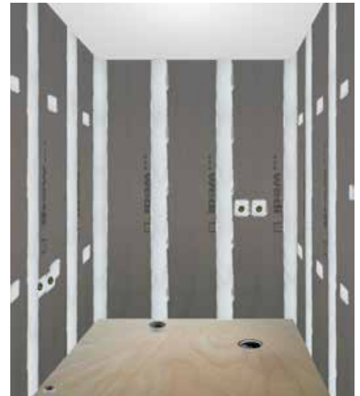
Lattiassa puupohjainen levyalusta.
