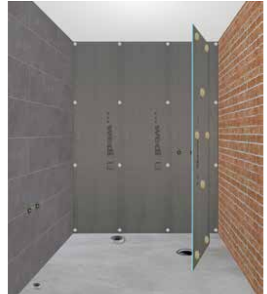
Oikaisu ja levytys pistekiinnitysmenetelmällä.
