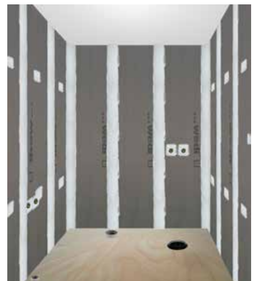
Asenna korokerengas puu-/betonialustan päälle.
