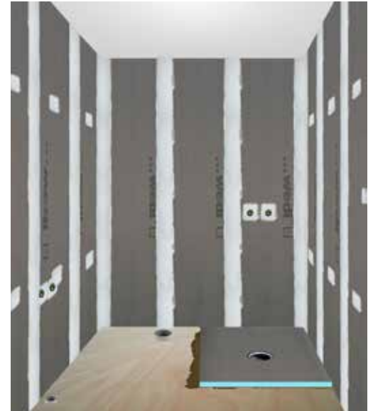
Asenna Fundo-kaivokappale paikoilleen.
