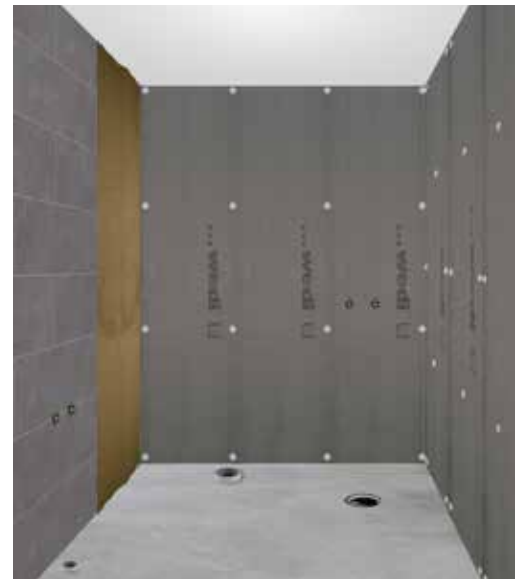
Seinän levyitys laastipeittomenetelmällä.
