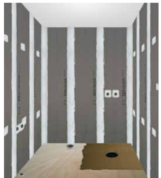
Levitä kiinnityslaastia kaivokappaleen alueelle.
