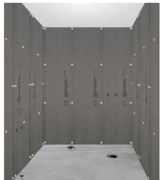
Vahvista kiinnikkeillä heti asennuksen edetessä.
