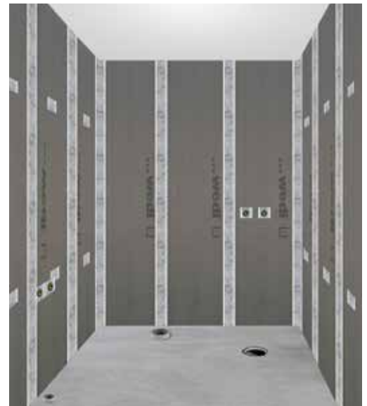
Tiivistä läpiviennit ja kiinnikkeiden kannat.
