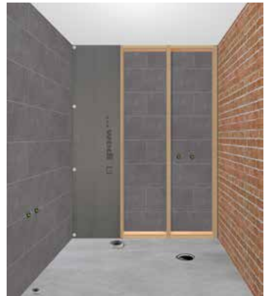
Kiinnitä ruuveilla ja wedi-aluslevyillä.
