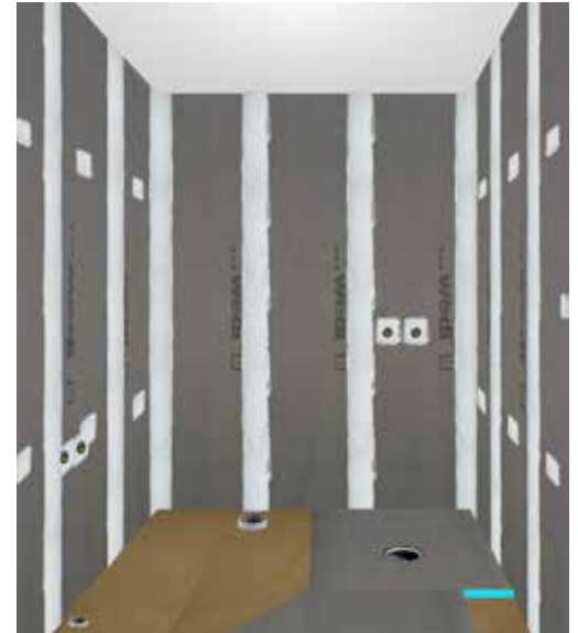
Jatka levytystä kaivolta pois päin.
