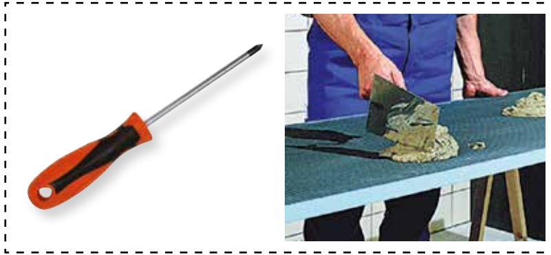
Oikaisu ja levytys pistekiinnitysmenetelmällä.
