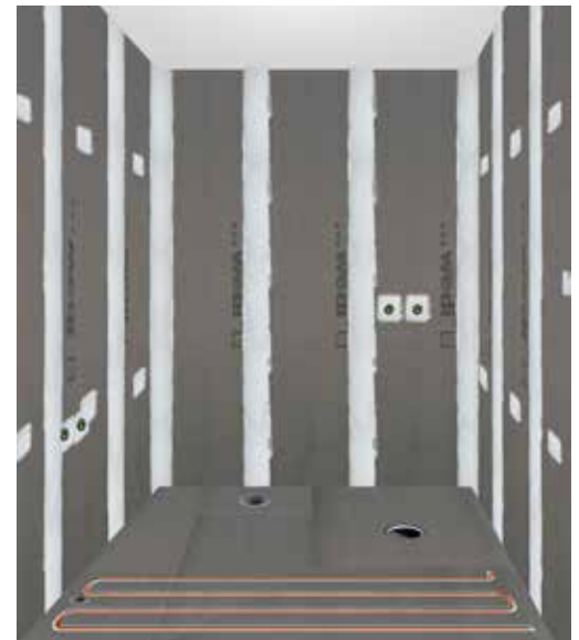
Lämmityskaapelin asennus tarvittaessa.
